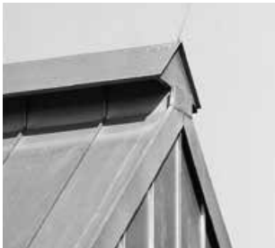
Billede 8: Rygningsafslutning ved vindskede, høj udførelse
