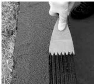
Billede 4: Enkolit® påføres med tandspartel
