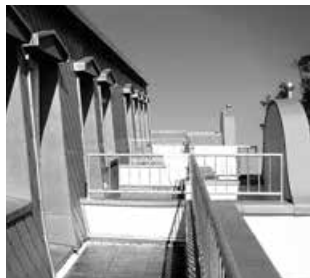
Billede 19: Anvendelse af RHEINZINK-bygningsprofil som murafdækning
