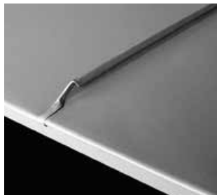
Billede 11: Pulftagsrygning som tagfodsafslutning
